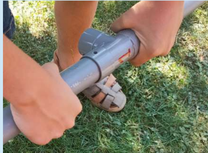
Un trou est nécessaire pour y insérer un collier
