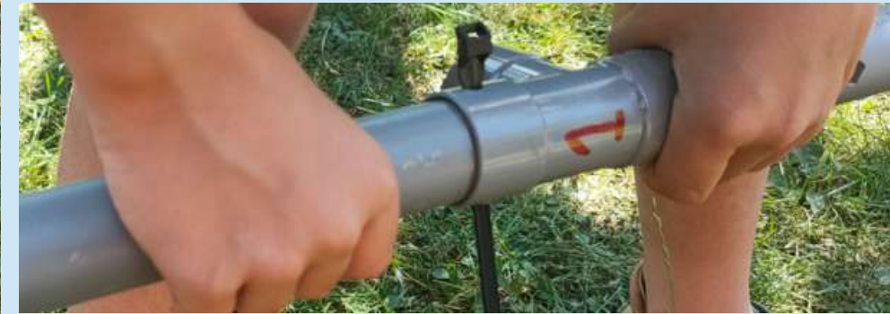
Un trou est nécessaire pour y insérer un collier
